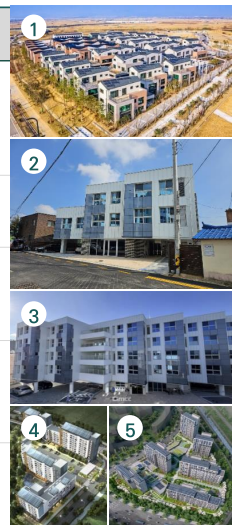
ZEB 3등급 이상 인증 공동주택 전경
