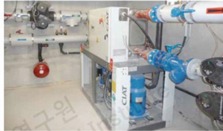
[그림 3-10] 프랑스 노인복지시설(EHPAD) 전경 및 지열냉난방 설비
