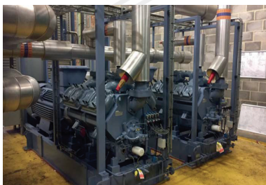
[그림 3-11] 영국 Lanchester Wines 음료 창고 지열난방시스템
